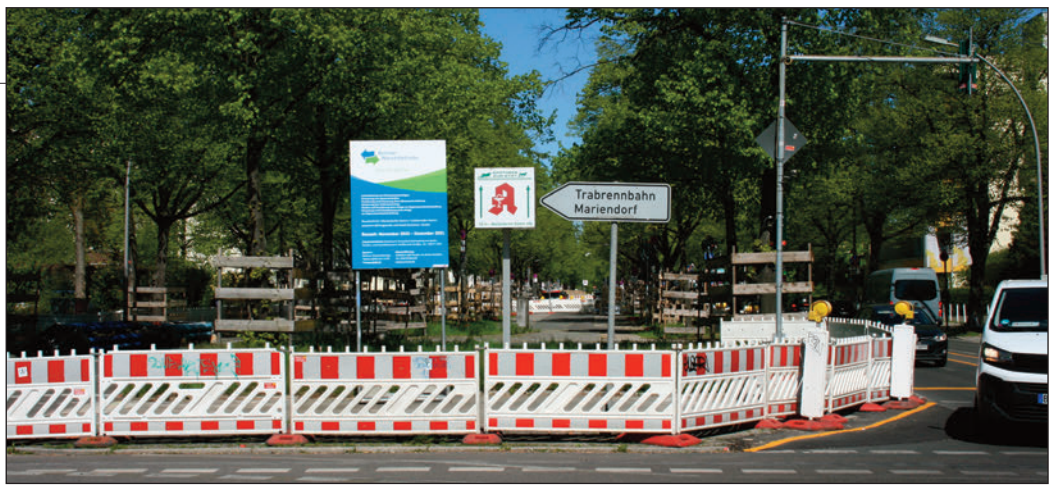
Nichts geht mehr: Der gesamte Mittelstreifen und die Fahrspuren in Richtung stadtauswärts sind abgesperrt.
