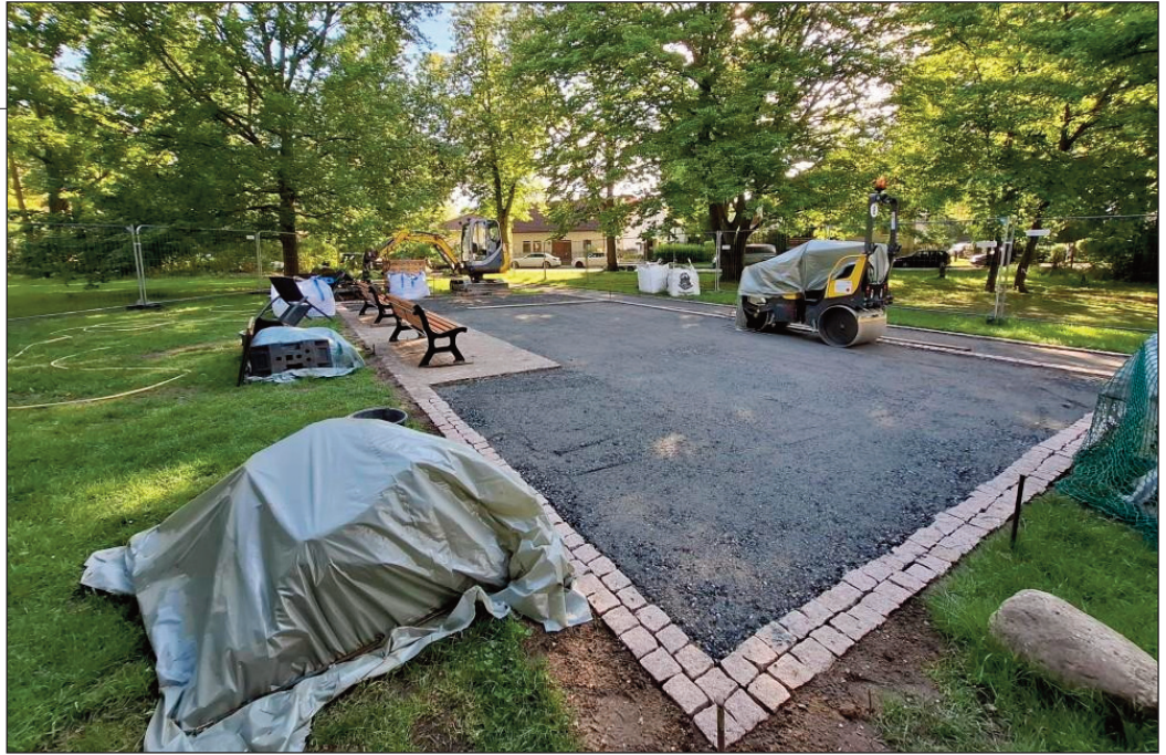
Hier entsteht der künftige Bouleplatz am Dorfteich.
